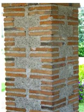
**Pilier carré** : Appareillé de briques chantignolles selon un chaînage d'angle alterné dit « en harpe », le pilier carré est un standard de l'architecture rustique à l'italienne.
