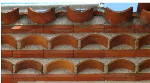
**Génoise** : Élément de la construction du toit formé de plusieurs rangs de tuiles creuses renversées et remplies de mortier.
